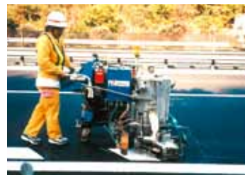
特許開発した自走式オートライナー (自動破線装置)
