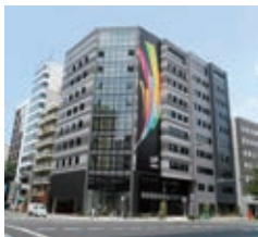
施工実績「大阪コミュニケーションアート専門学校」
