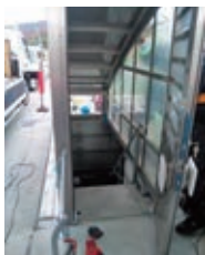
高速料金所の階段でフェリーの運搬を行った
