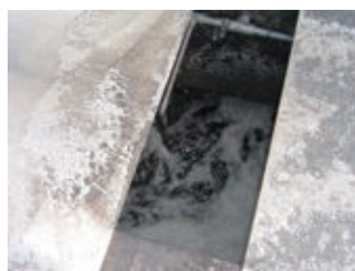
曝気槽の状況
