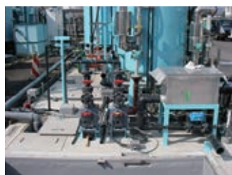
液中膜処理設備。膜分離ポンプ配管工事中
